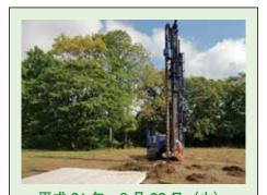
平成 21 年 9月 22 日 (火) 万が一の地震などに備え、基礎部分には長さ3mのコンクリートの杭を打ち込みます。 最初にドリルで土を掘って、その穴に杭を埋め、杭の頭を油圧で押し込みます。
