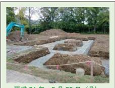
平成 21 年 9月 28日 (月) 基礎部分に沿ってパワーショベルで素掘り した跡に砕石が敷かれ、その上にコンクリー ト基礎用の型枠が組み立てられています。
