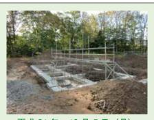
平成 21 年 10 月 5 日 (月) 基礎の方枠を組む作業を容易にするために、 建物の中心部分に足場が組まれています。
