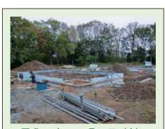
平成 21 年 10 月 8 日 (木) 礎部分の型枠が組まれ、断熱効果を高めるため F P板(発泡断熱材)が基礎のコンクリートの外側を覆うようになっています。これも近年の北国の住宅建築の特徴です。
