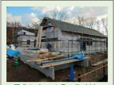
平成21年 12月1日(火) 和風型の屋根もトタンが張られました。 壁には朱色の断熱材が充填され、その上に 雨の侵入を防ぐシートが張られています。 北海道としては暖かく工事もスムーズです。
