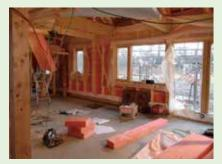
平成21年 12月2日 (水) 和風型の室内です。 サッシの内側は木製で温もりが伝わります。 しっかりと断熱材が収まっています。
