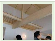
平成 22 年 2 月 10 日 (水) 和風型の天井の仕上げは吹き抜けで、梁材を見せるなどの工夫をしています。
