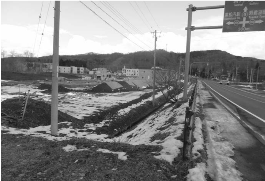
建設にとりかかった黒松内つくし園職員宿舍
