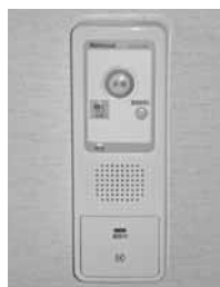
緊急通報装置
