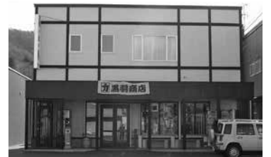
店のしつらい魅力向上事業を活用して改修された
