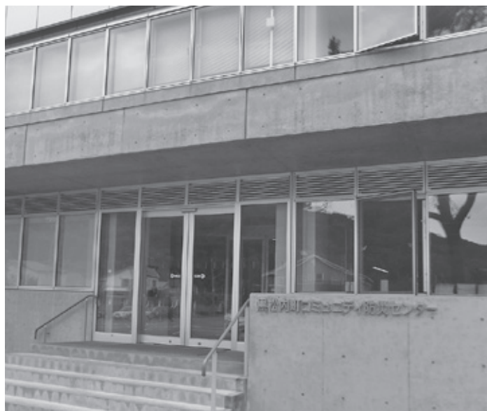
災害時に司令塔となるコミュニティ防災センター
