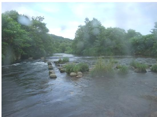
図 1-2 東栄橋下流の帯工
