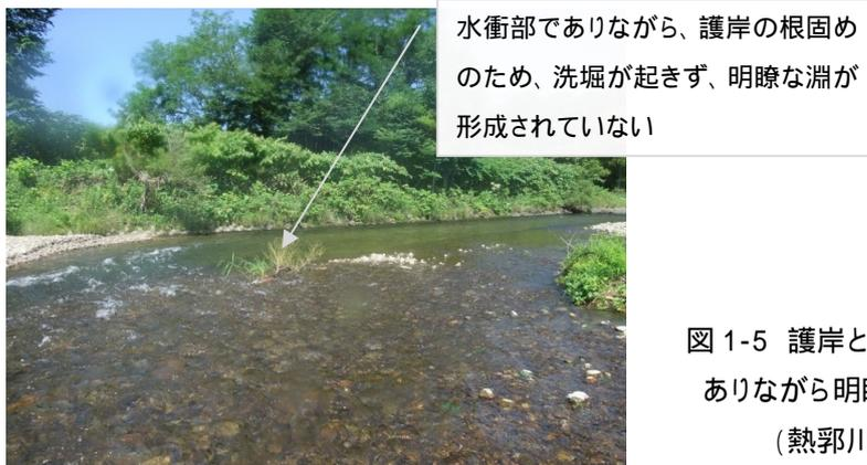
図 1-5 護岸とその根固めのために水衝部でありながら明瞭な淵ができていない事例
