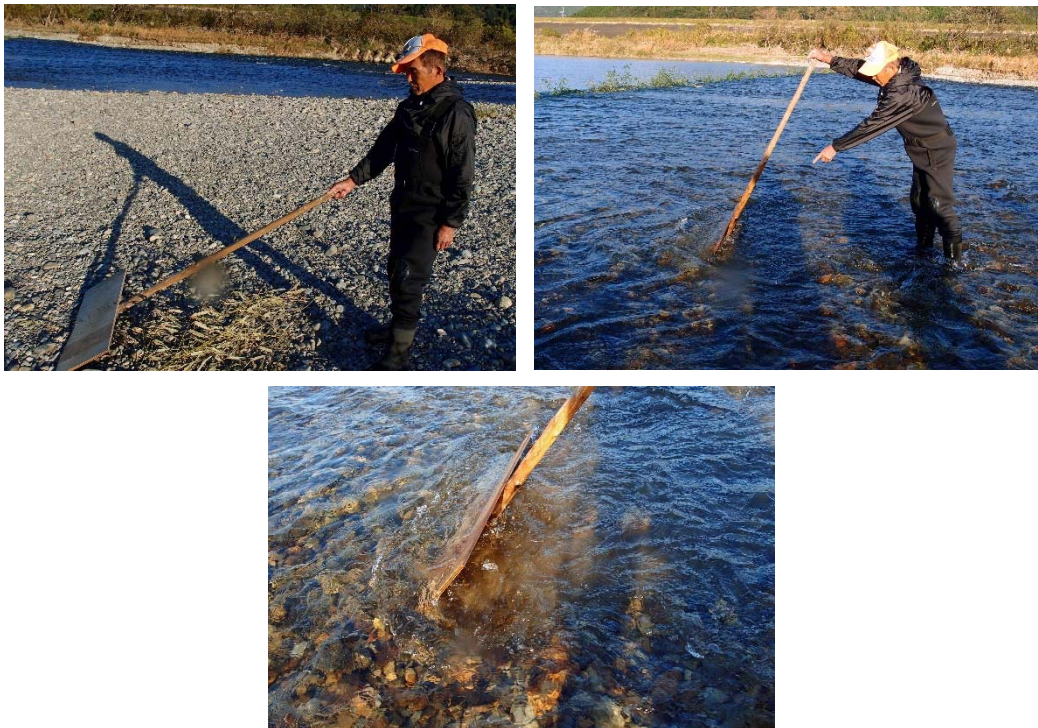
図 3-12 河床の砂泥を抜くための木製プレート(宮崎県北川で瀬付き場を作るために使用)
