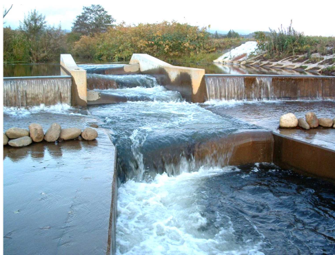
尻別川支流倶登山川の農業用落差工に設置された魚道 (倶知安町)
