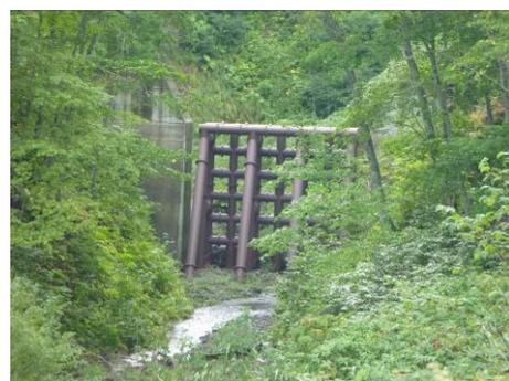
中央部分に鋼鉄を格子状に組んだ構造物を設置したダム（中の沢川）
