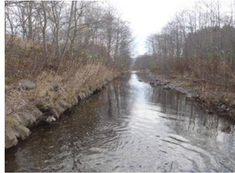
流れが直線化され、コンクリートブロックで護岸された賀老川
