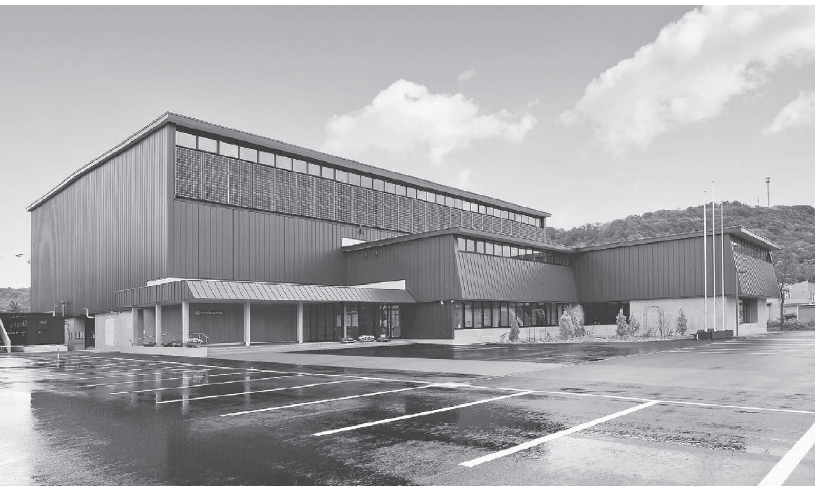
総合体育館外構工事完了 10月10日撮影
