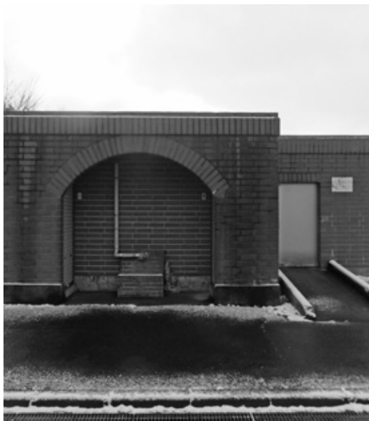
野球場の屋外トイレ
